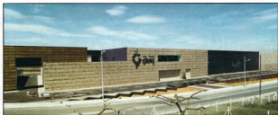
Façana exterior de les noves instal·lacions de Vins i Licors Grau.
